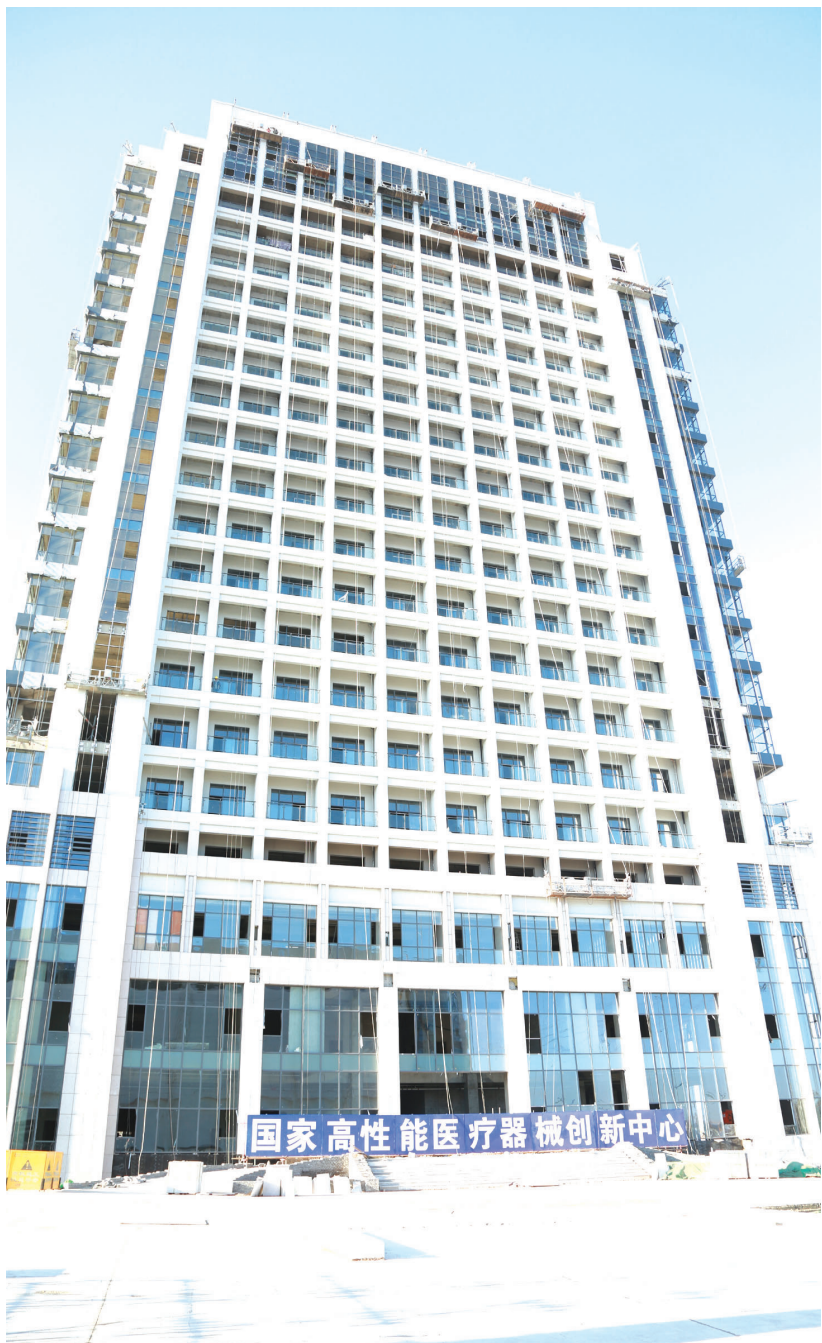
园区内,国家高性能医疗器械创新中心正在进行室内外装修。
